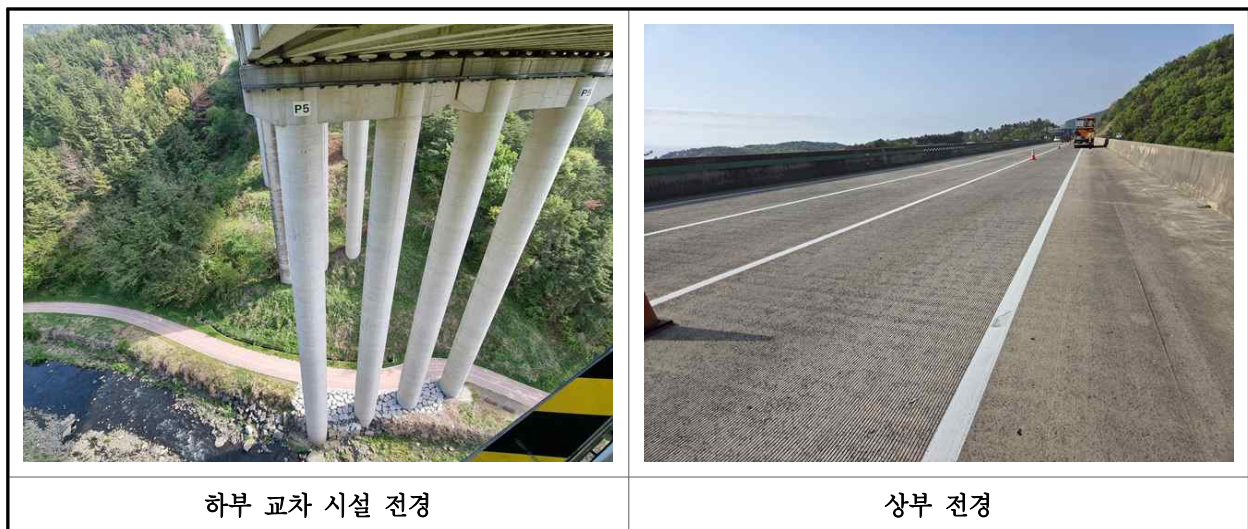
【사진 42.2.1】 주변환경 및 하중변화 전경
