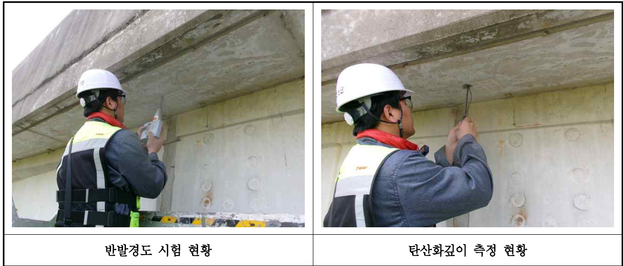
【사진 42.4.1】 콘크리트 내구성조사 현황
