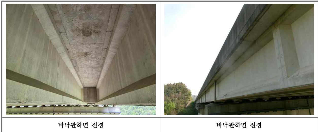
【사진 42.3.2】 바닥판하면 전경
