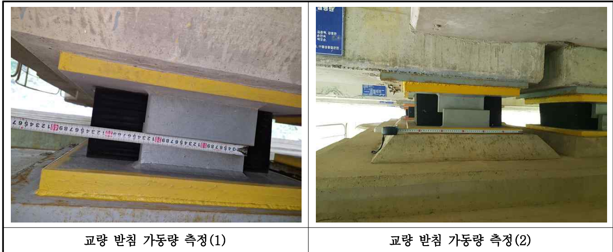
【사진 42.3.16】 교량받침 이동량 측정
