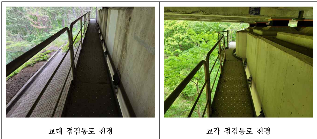
【사진 42.3.26】 교량 점검시설 전경
