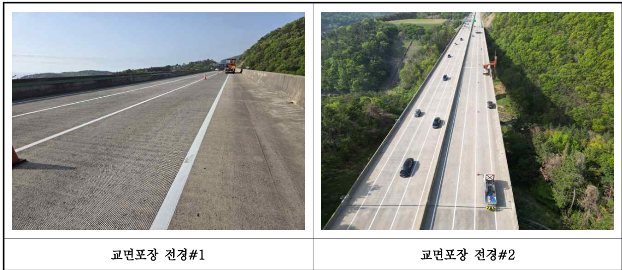
【사진 42.3.20】 교면포장 전경
