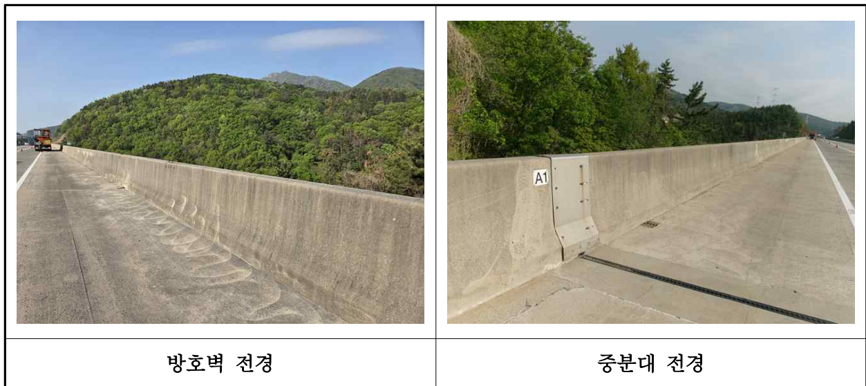
【사진 42.3.24】 방호벽 및 중분대 전경
