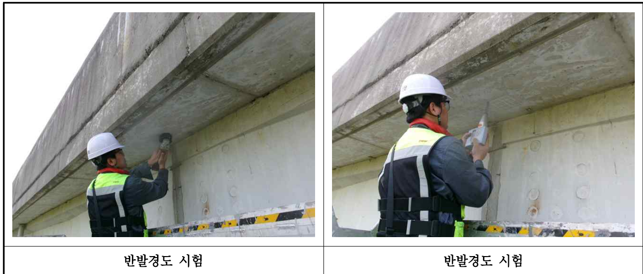
【사진 42.4.2】 반발경도시험 현장사진
