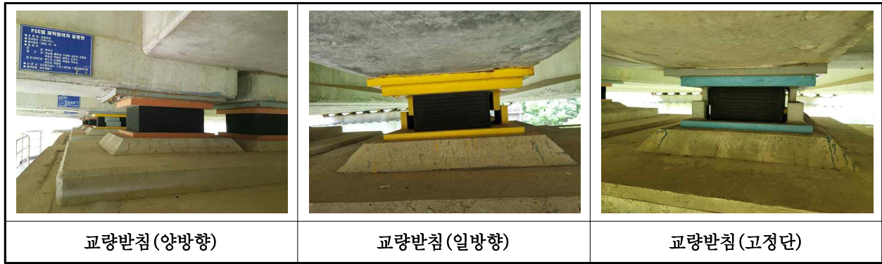
【사진 42.3.13】 교량받침 전경
