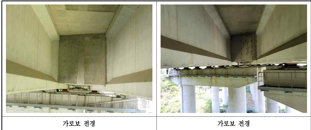
【사진 42.3.6】 가로보 전경
