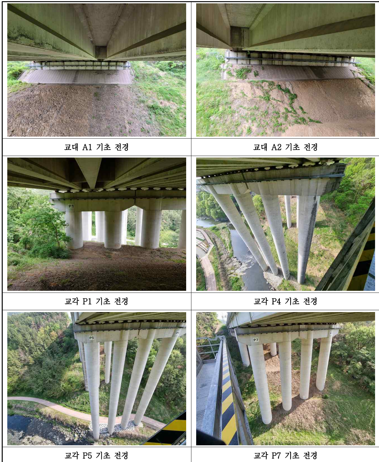
【사진 42.3.12】 기초 전경
