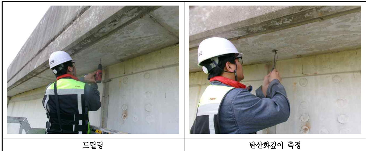
【사진 42.4.3】 탄산화 깊이 측정 현장사진
