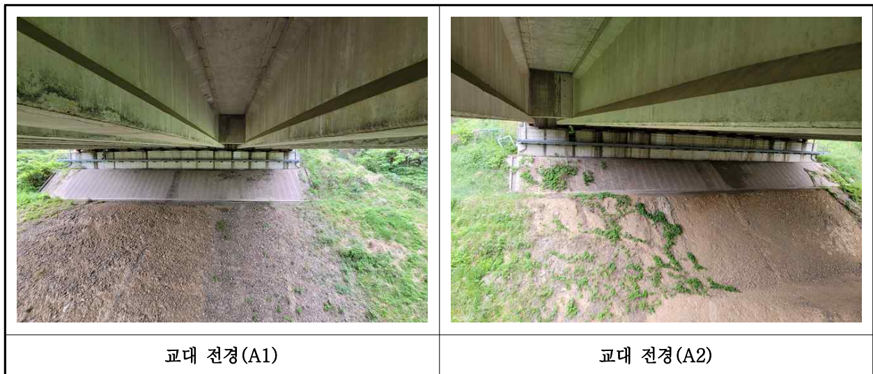
【사진 42.3.8】 교대 전경
