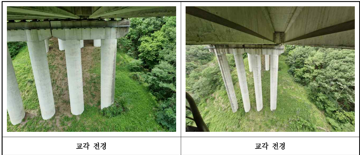
【사진 42.3.10】 교각 전경
