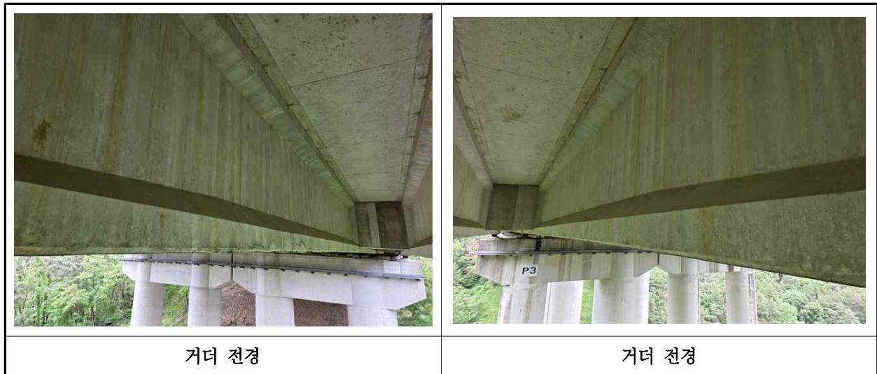
【사진 42.3.4】 거더 전경
